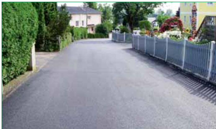
Mukenhams: Teilweise Erneuerung des Tragkörpers, Abfräsen sowie Einbau einer neuen Asphaltdecke, Herstellung neuer Kanalananschlüsse.
