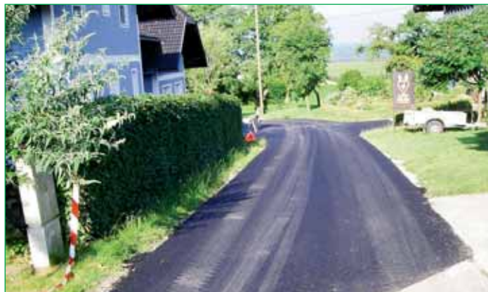
Sinzing: Abfräsen und Sanierung der Asphaltdecke
