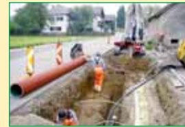
GEH- UND RADWEG ERNSTING Arbeiten neigen sich dem Ende zu
