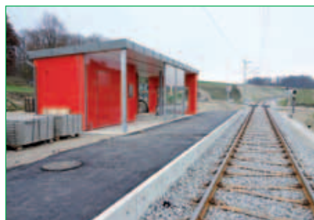
Haltestelle und Bahnübergang Diepoltsdorf
